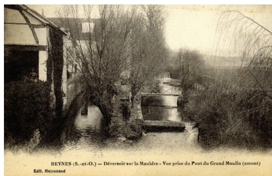
BEYNES (S.-et-O.) – Déversoir sur la Mauldre - Vue prise du Pont du Grand Moulin (amont) Edit. Meynaud Le Grand Moulin et son canal de fuite, ou « fausse rivière » Carte postale, vers 1900-1910. Copyright : Archives municipales de Beynes
